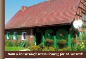
Dom o konstrukcji szachulcowej, foto. M. Staszak
